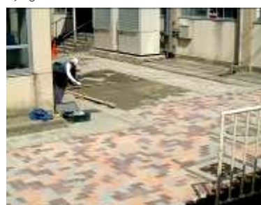
インターロッキングの工事
